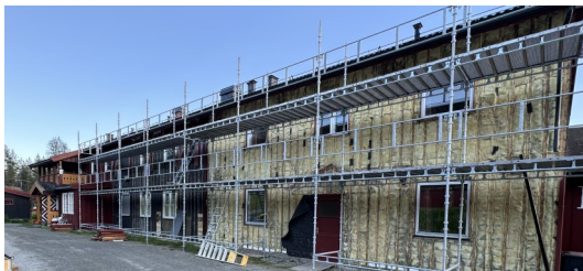
Undervejs til ny facade
